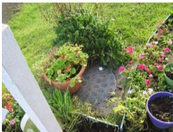
Vue du déversoir d'orage au 85 rue des Bosquets
