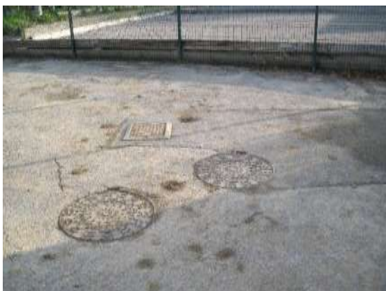
Vue du déversoir d'orage allée Yves Dorée
