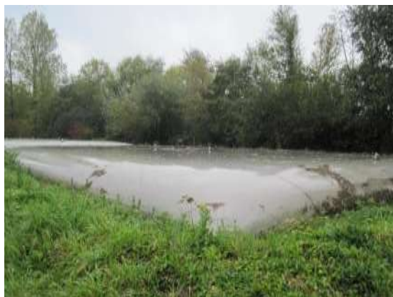
Vue des citernes souples de stockage des boues.
