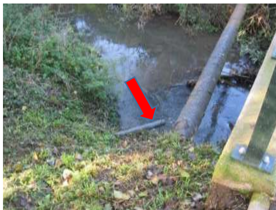
Vue du point de rejet des effluents dans la Lédre
