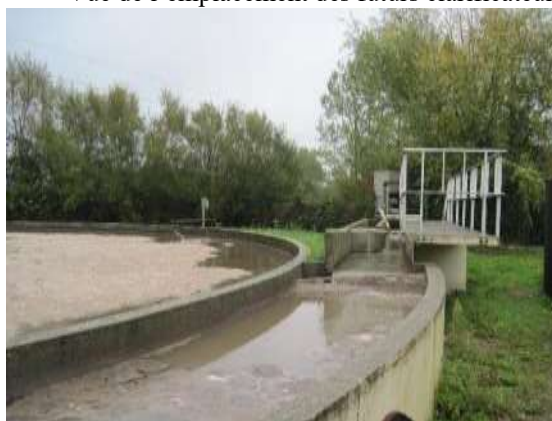
Vue de la partie droite du clarificateur actuel
