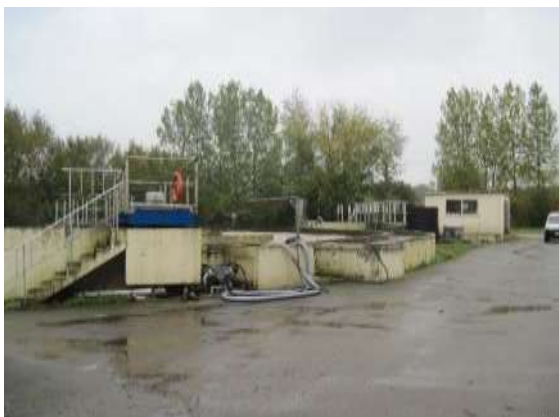
Vue générale de la station d'épuration
