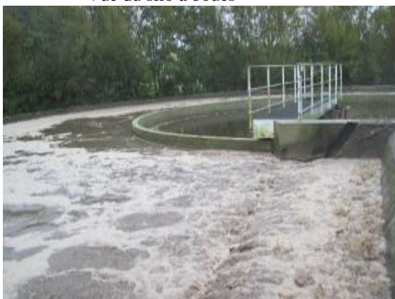
Vue de la partie gauche du clarificateur actuel
